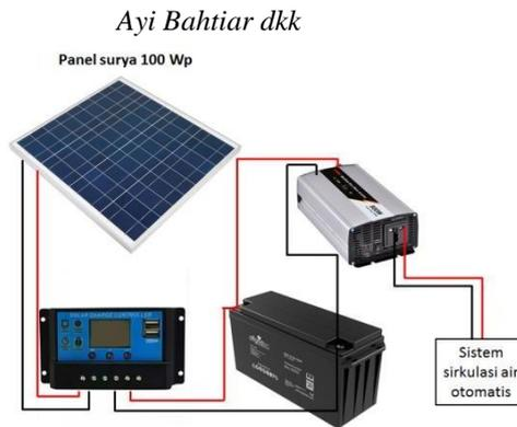
**Gambar 2.** Panel surya untuk sistem sirkulasi air kolam
