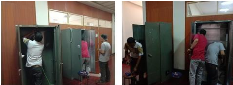
Gambar 2. Proses Perakitan Lemari Disinfeksi UV-C
