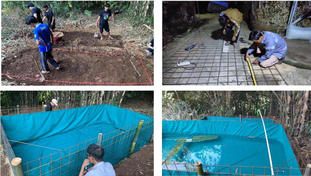
**Gambar 1.** Foto proses perataan tanah, pembuatan pondasi, pemasangan kolam terpal dan pengisian kolam.
