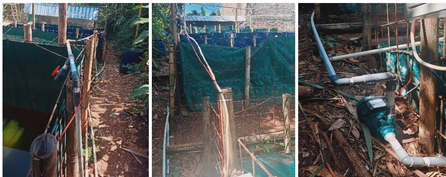
Gambar 3. Foto-foto kegiatan pemasangan panel surya dan sistem sirkulasi air kolam
