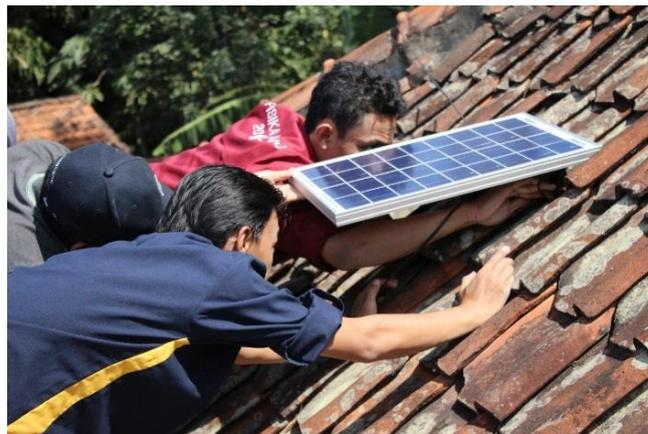
**Gambar 3.** Tahap instalasi panel surya di atap.
