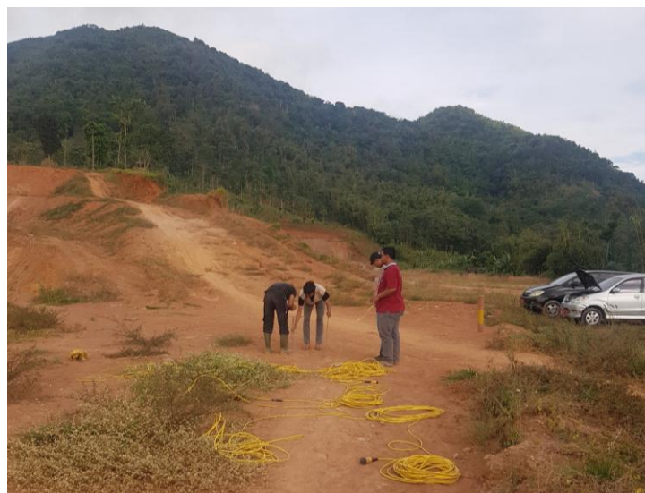
Gambar 5. Kondisi lereng bekas pengerukan
