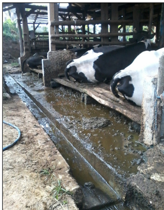
Gambar 1. Kandang sapi pada awalnya masih menggunakan lantai kayu tampak genangan air kotor bercampur feses sapi
