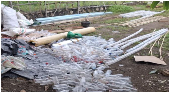
Gambar 1. Bahan dinding rumah garam dari daur ulang botol plastik.
