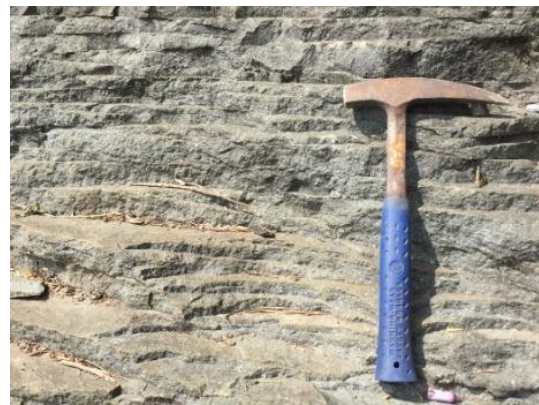
Gambar 1. Kenampakan struktur sheeting joint pada NN 16
