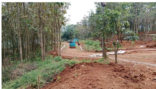
Gambar 2. Pembangunan (Sirkuit) di Kawasan Arunika, Desa Cisantana
