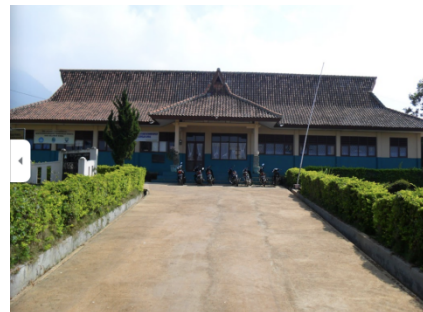
Gambar 2. Gedung SMPN 3 Jatinangor (Sumber: Diki, 2019)
