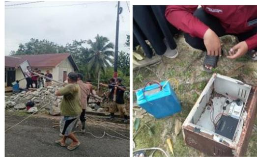
**Gambar 3. Penurunan Tiang PJUTS dan Kotak Panel PJUTS yang Terlihat Berkarat dengan Komponen yang Tidak Berfungsi**
