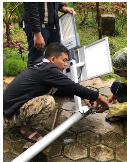
Gambar 5. Instalasi PJU-TS pada Tiang Lampu
