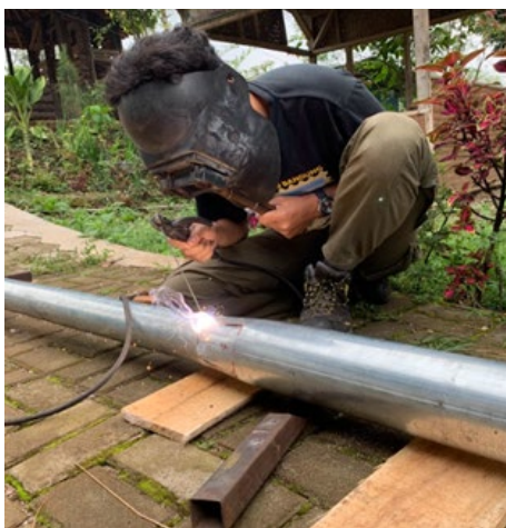
Gambar 4. Pengelasan Tiang PJU-TS (Sumber: Dokumentasi KKN TRM Polman Bandung, 2022)
