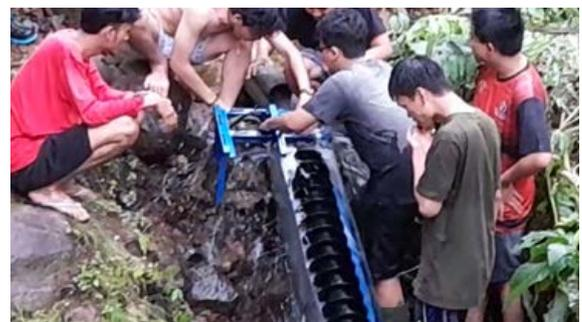
**Gambar 2. Pemasangan turbin ulir *Archimedes***
