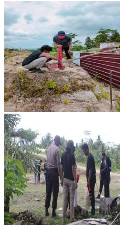
**Gambar 3. Pembuatan dan pemasangan patok penanda batas areal kampus**
