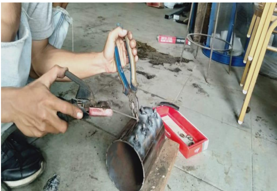
Gambar 2. Pemasangan Mata Taji Roller
