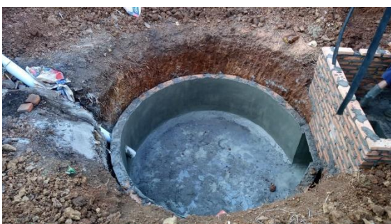
Gambar 1. Proses Pembangunan Instalasi Reaktor Biogas Fixed Dome (Sumber: Dokumentasi Pribadi, 2024)
