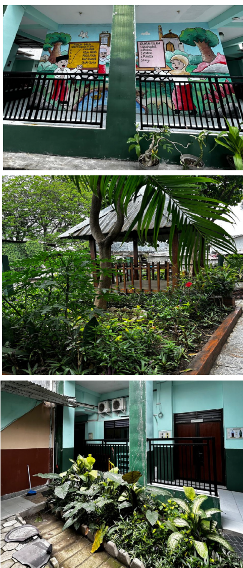
Gambar 1. Kondisi Sekolah dan Taman (Sumber: Dokumentasi Penulis, 2025)
