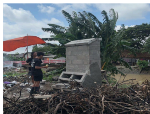
Gambar 3. Tahap Finishing Pembuatan Incinerator
