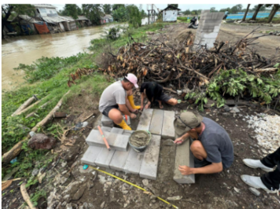
Gambar 1. Tahap Persiapan Pembuatan Incinerator
