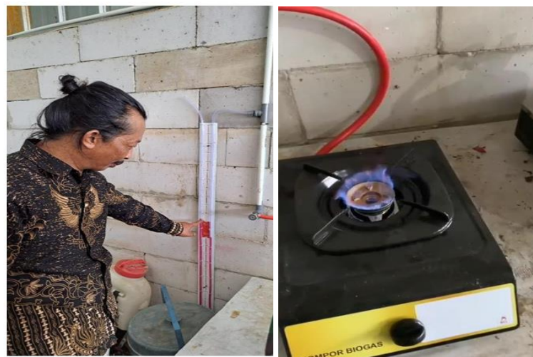
Gambar 5 (a) dan (b) Penerapan prototipe Biodigester yang sudah dialirkan ke rumah warga sebagai alternatif energi biogas
