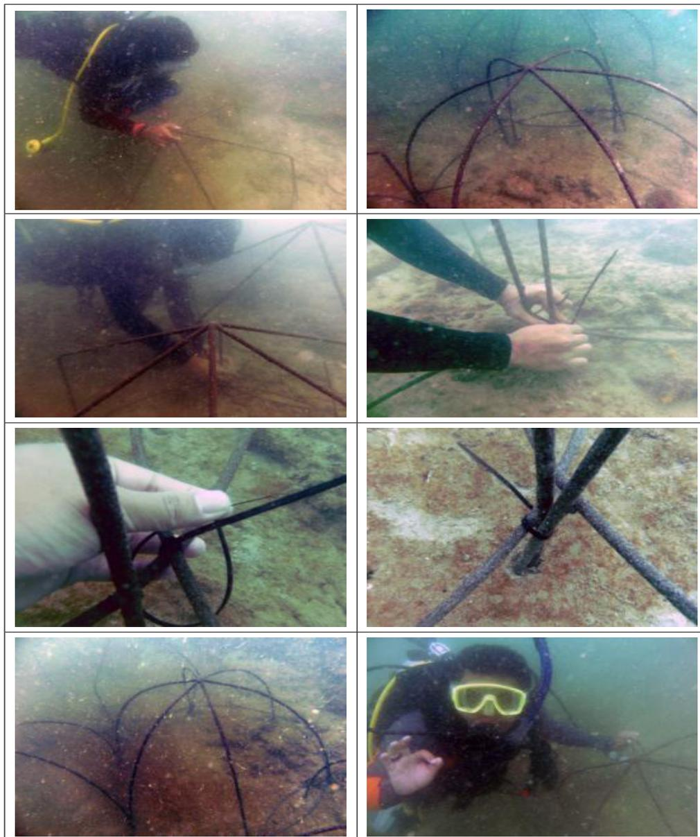
**Gambar 5. Penurunan dan Penyusunan Raksagon di Bawah Air**
