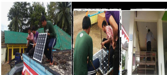
Gambar 3. Pemasangan panel PV diatap, Pemasangan panel PV 65 W dan 4 W.
