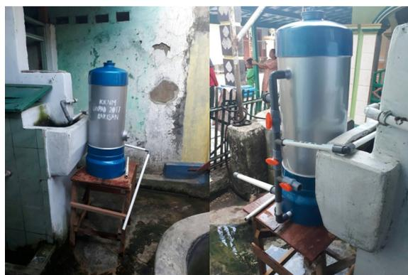
**Gambar 5.** Filter air yang diberikan ke Desa Barisan dan Desa Astana Langgar untuk praktek pengolahan air payau rumah tangga
