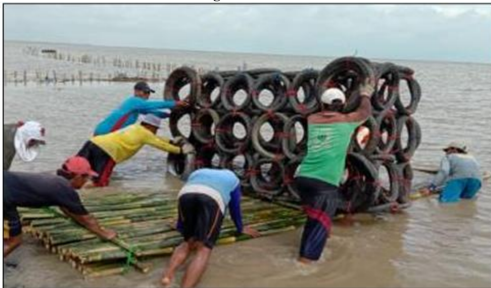
Gambar 2 Pemasangan APPOSTRAPS
