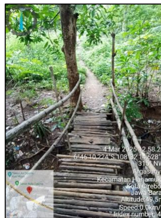
Gambar 3. Kondisi Jembatan dengan konstruksi non-permanen di dalam Permukiman
