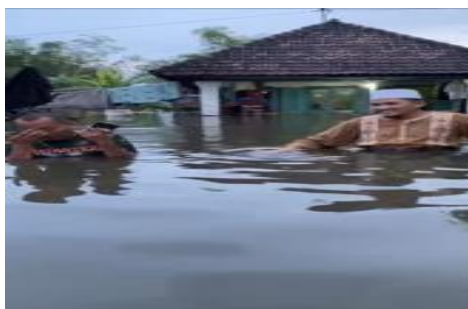
Gambar 2. Kondisi banjir di Dusun Balungrejo
