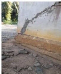
Foto 6. Dinding Retak.
